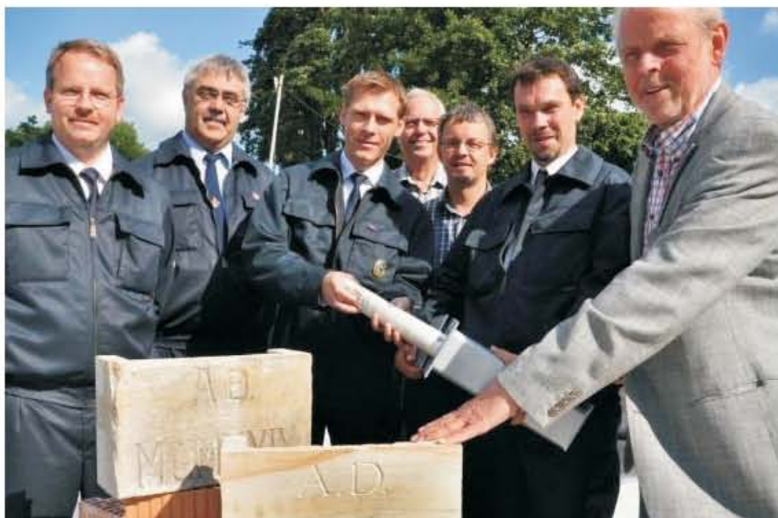
Der Grundstein für das neue Gerätehaus des Löschzugs Altstadt wird mit dem Grundstein des alten Hauses von 1929 eingebaut. (Foto: Berthold Fehmer)
