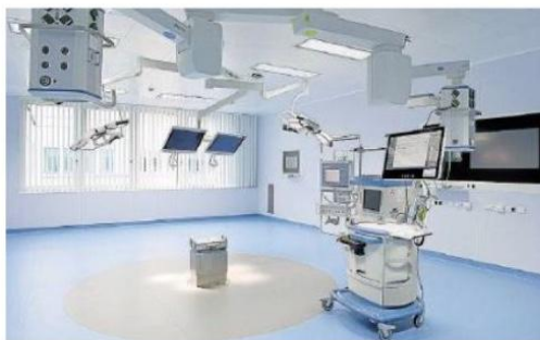
In zwei Bauabschnitten wurden bereits zehn Operationssäle am Campus Benjamin Franklin modernisiert. Die Thieken GmbH ist nun für fünf weitere OPs zuständig. FOTO WIEBKE PELZ
