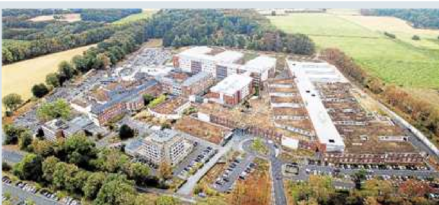
Am Krankenhaus St.-Franziskus in Mönchgladbach haben THIEKEN + PARTNER bereits mehr als 200 Millionen Euro verbaut. Der Krankenhausbau ist schon seit den Anfängen ein fester Bestandteil der Aufgaben von THIEKEN + PARTNER. FOTOS (2) PRIVAT
